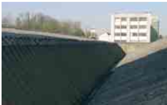
Zuntz-zementua. Amianto ez hauskorra.
