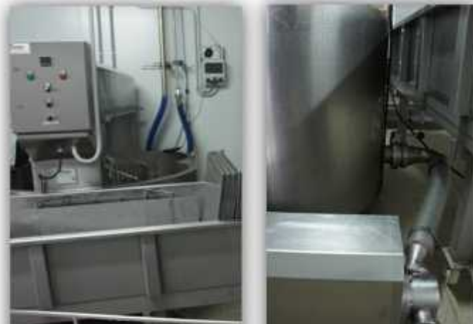
Foto izq.: Cuba al fondo y mesa desuerado en primer plano Foto drcha.: Bomba de trasiego
