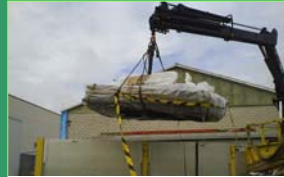
MCA retirado, embalado y etiquetado, que se transporta a gestor de residuos
