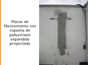
Placas de fibrocemento con espuma de poliuretano expandido proyectado
