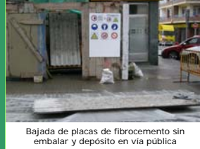
Bajada de placas de fibrocemento sin embalar y depósito en vía pública
