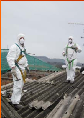
Trabajadores con EPI's respiratorio y de caída en altura
