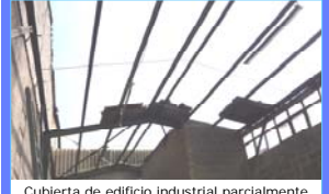
Cubierta de edificio industrial parcialmente retirada y sin protecciones colectivas contra el riesgo de caída en altura
