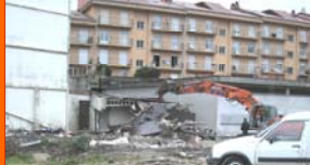
Retirada de cubierta de fibrocemento con tela asfáltica, empleando maquinaria de movimiento de tierras
