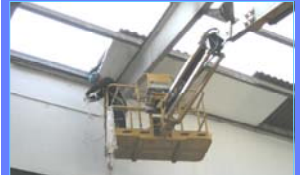
Uso de PEMP para colocación de protecciones colectivas o acceso
