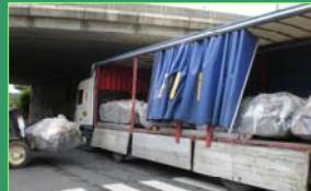
MCA retirado, embalado y etiquetado, que se transporta a gestor de residuos
