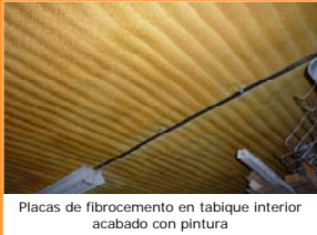
Placas de fibrocemento en tabique interior acabado con pintura
